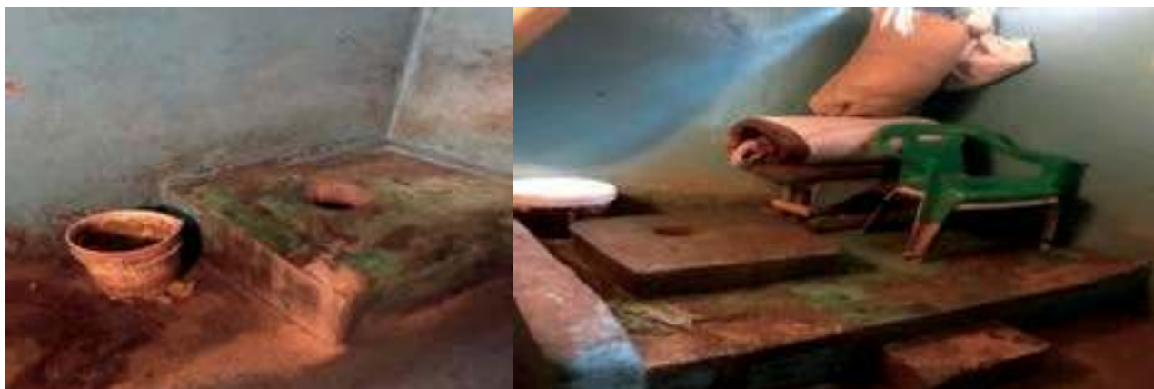
Vista de los baños.
