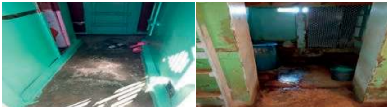
Condiciones del interior de las celdas.
