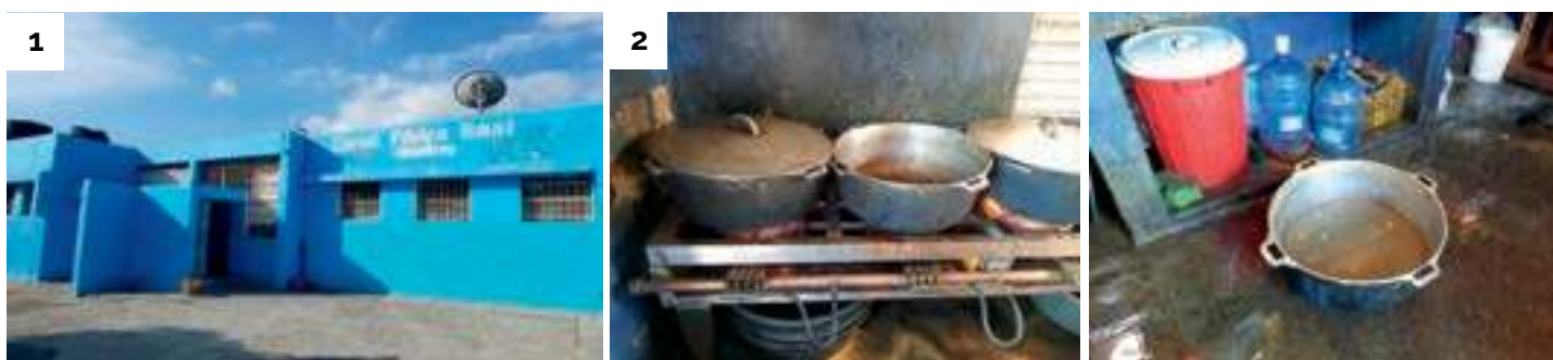
1. Fachada de la cárcel pública de Bani. 2. Área de la cocina.
