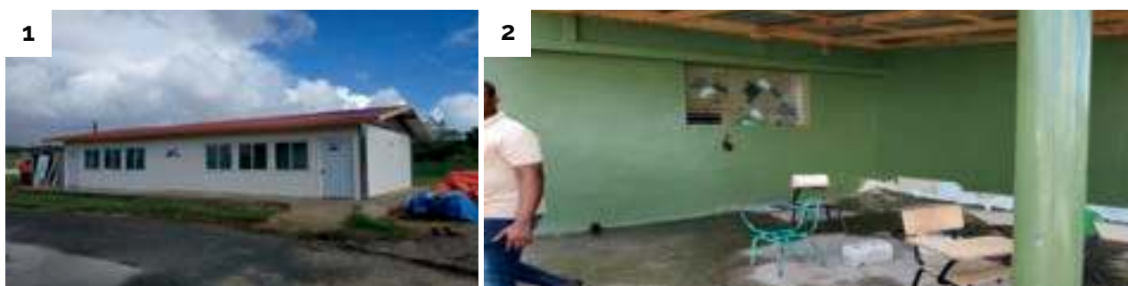
1. Construcción de aulas de INFOTEP. 2. Vista del espacio utilizada como área educativa.
