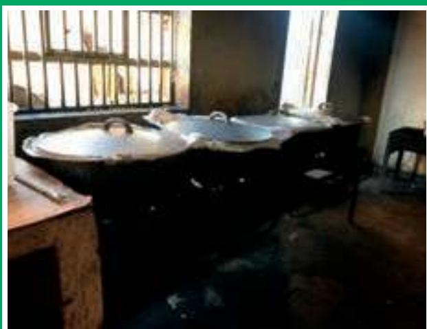
Vista del área de la cocina.
