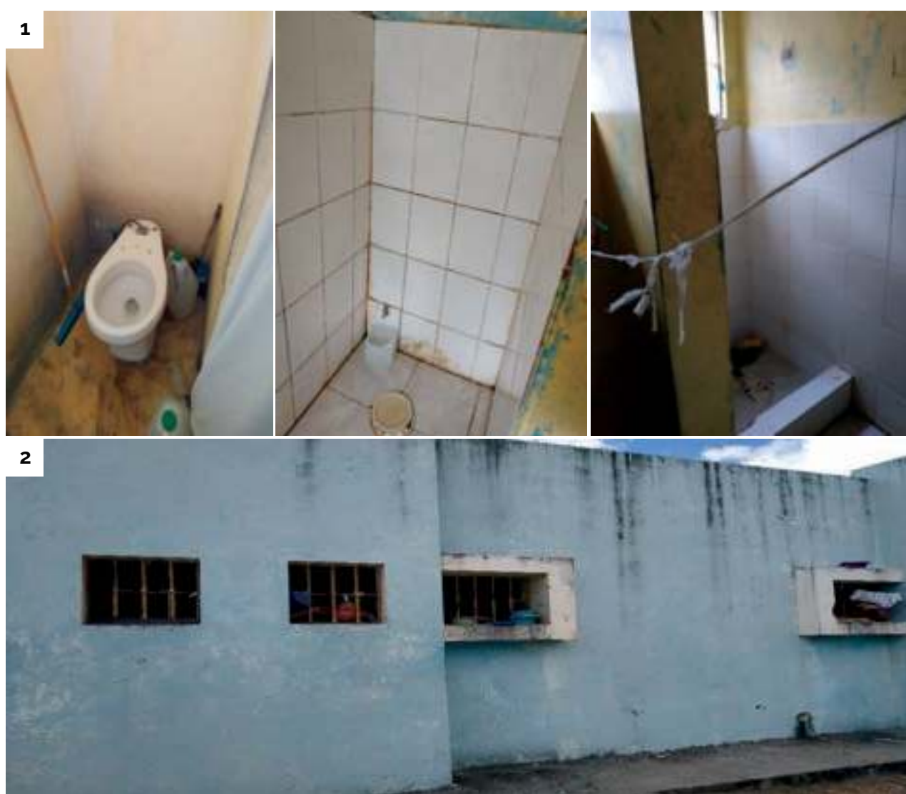
1. Vista de los baños. 2. Vista externa de las celdas de reflexión.
