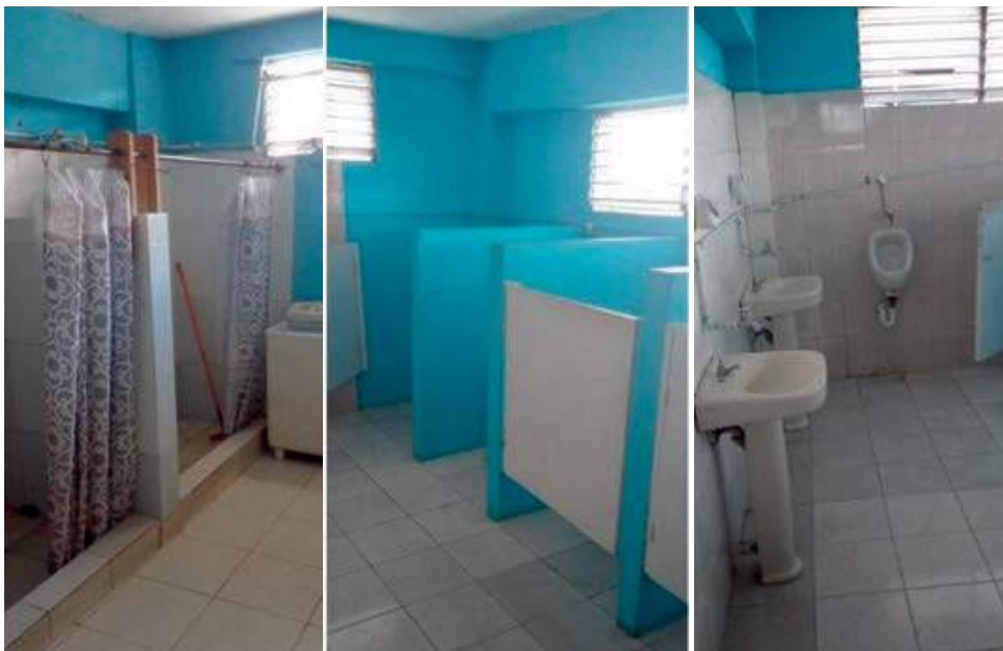
Vista de los baños, también utilizados como área de lavado.
