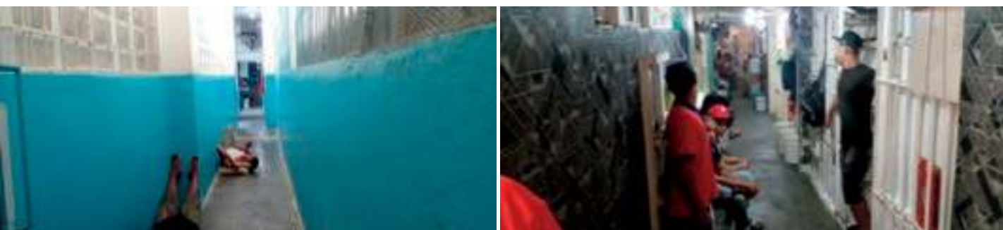
Vista de las cubetas en los pasillos, utilizadas para guardar utensilios.
