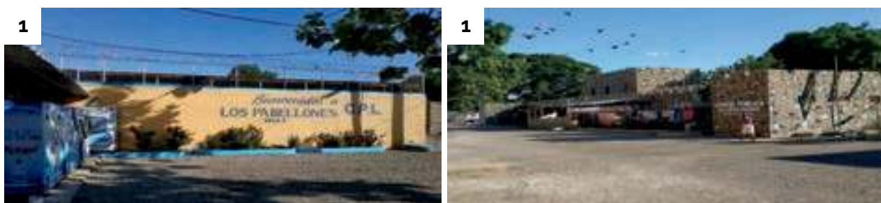
1. Vista del pabellón Vega 2. Pabellón de los Veteranos.
